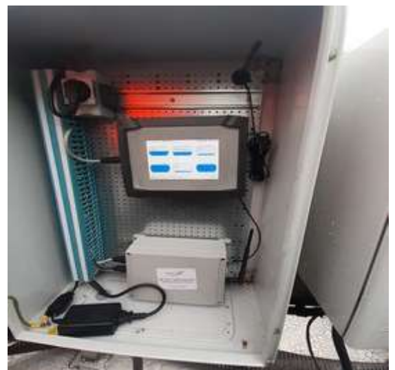
Système de gestion des niveaux de cuve
