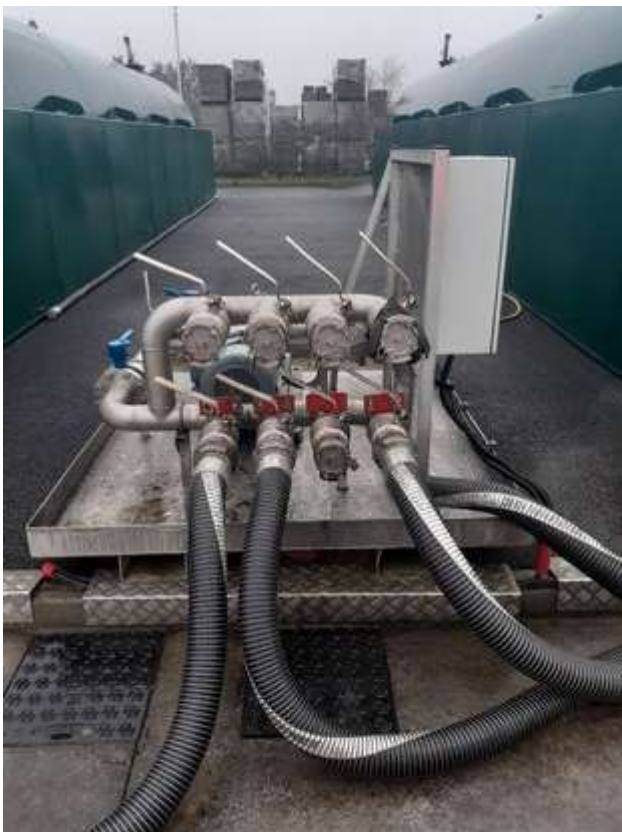
Système de vannes permettant de chargement/déchargement des camions
